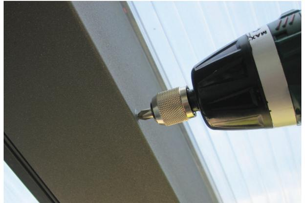
2.) Löcher in den Sparren vorbohren.
