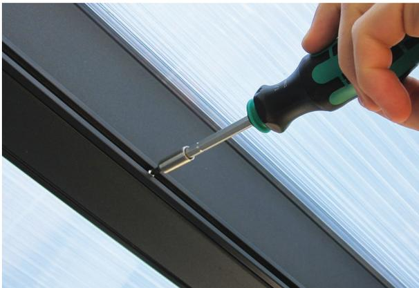
3.) Längsprofil anschrauben.
