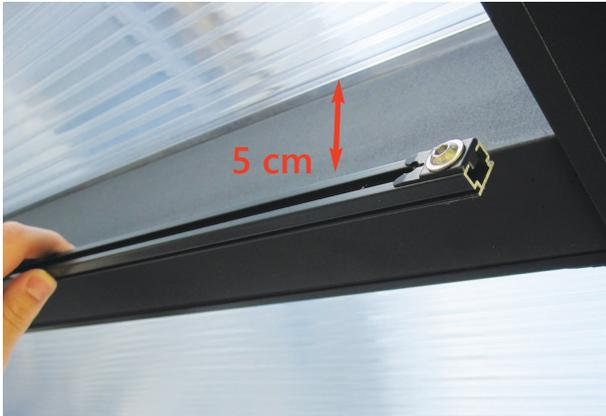
1.) Längsprofil an den Sparren halten, Löcher anzeichnen. Empfehlung: Alle 50 - 100 cm (Schiene ist alle 50 cm vorgebohrt)
