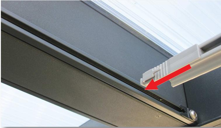
4.) Klettprofil mit dem beweglichen Gleiter (lang) als erstes in das Längsprofil klipsen.
