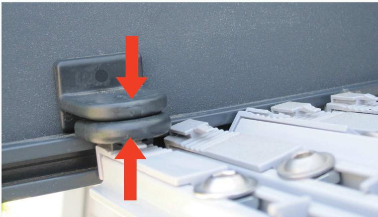
10.) Das Paket (alle Klettprofile) je nach Wunsch zur Haus- oder Gartenseite schieben. Den Gegenmagnet (Wandhalter mit Magnet) zum Anschrauben oberhalb des Längsprofils positionieren.
