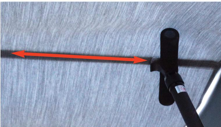
13.) Drücken Sie nach dem Ankletten die Behänge entlang der Klettstreifen mit Hilfe des Bedienstabs noch einmal richtig nach!
