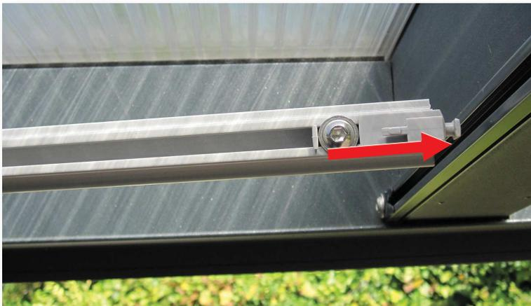
5.) Dann die Seite mit dem feststehenden Gleiter (kurz) in das gegenüberliegende Längsprofil klipsen. Klettprofil schwenkt dann beim Loslassen 90° nach unten in die richtige Position.
