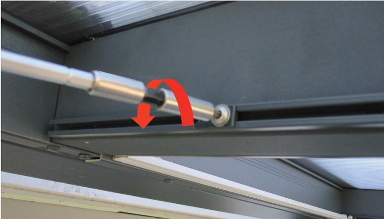
6.) Den Stopper an der Hausseite im Längsprofil lösen und die Stopper-Öffnung in Richtung Hausseite drehen.
