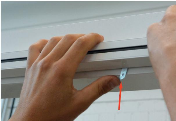
3.) Die Sicherung bis Schienenkante reindrücken (Sicherung befindet sich am Spannriegel)
