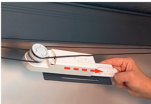
10.1) Motor auf die Grundplatte schieben.
