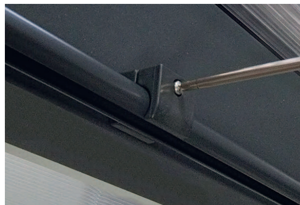
Hinweis: Bei Anlagen ab 2000 mm Breite liegt ein weiteres Längsprofil bei (ohne Zugschnur). Dieses gemäß Punkt 1.) bis 5.) etwa mittig montieren.
