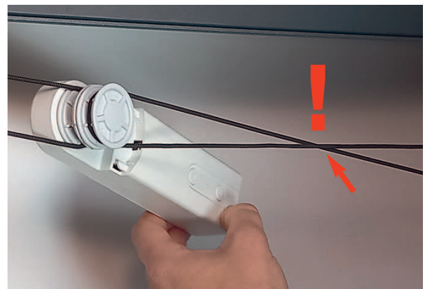
9.1) Die zweite Schlaufe der Zugschnur drehen und locker um die vordere Rolle des Motors legen. Dazu ggf. die Anlage justieren und spannen.
