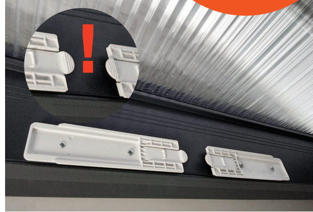
7.2) Halterungen am Querprofil anbringen in Richtung wie abgebildet. Abstand zu den seitlichen Schienen 200 mm. Der Abstand zwischen den Motoren variiert.
