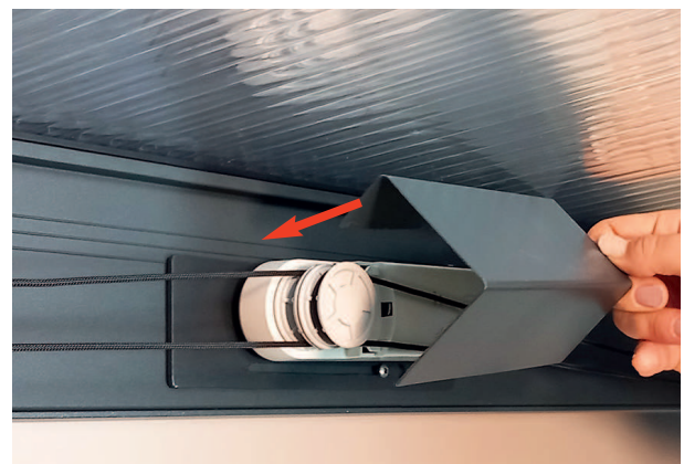
11.1) Montageplatte mit Motor am Querprofil locker anschrauben. Abdeckkappe zwischen Montageplatte und Querprofil klemmen. Schrauben der Montageplatte festziehen. Bei Bedarf nachspannen (Punkt 12. und 13.), fortfahren mit Punkt 14.)
