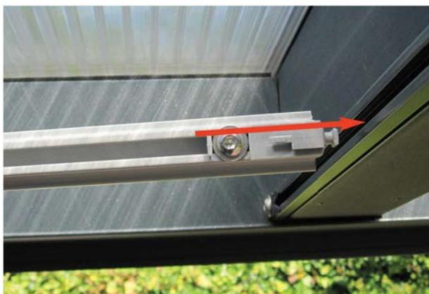
5.) Dann die Seite mit dem feststehenden Gleiter (kurz) in das gegenüberliegende Längsprofil klipsen. Das Klettprofil schwenkt beim Loslassen 90° nach unten in die richtige Position.
