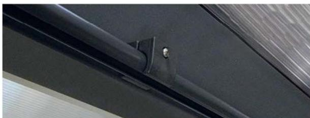
Bei Montage über mehrere Felder muss der Trägerclip bündig zur Unterkante des Sparren montiert werden.
