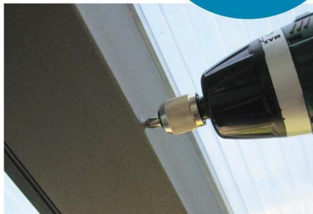
2.) Löcher in den Sparren vorbohren.
