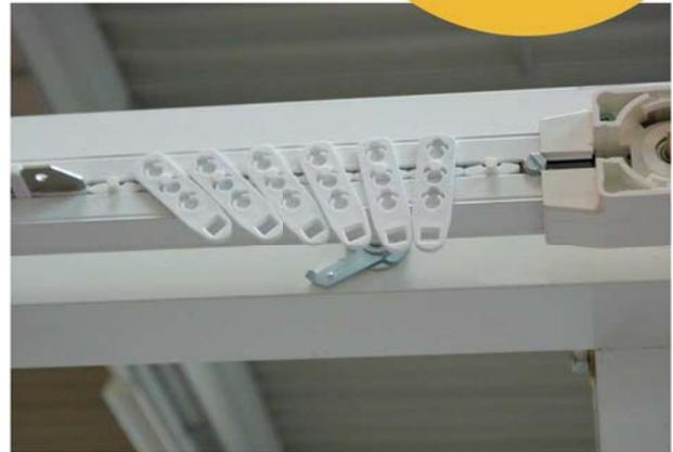
2.) Schiene montieren. Dabei darauf achten, dass **auf der Motoreseite ein Spalt** zur Wand gelassen wird, zum Anbringen der Winkelblende.
