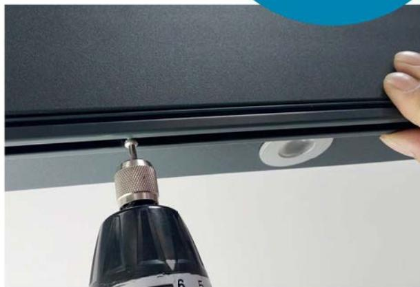
2.) Längsprofil unter dem Sparren anschrauben.
