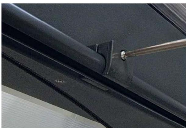
5.) Das Längsprofil in den Clip einlegen - **Laufen** senkrecht nach unten! Dann die Trägerclip-Schraube festziehen.
