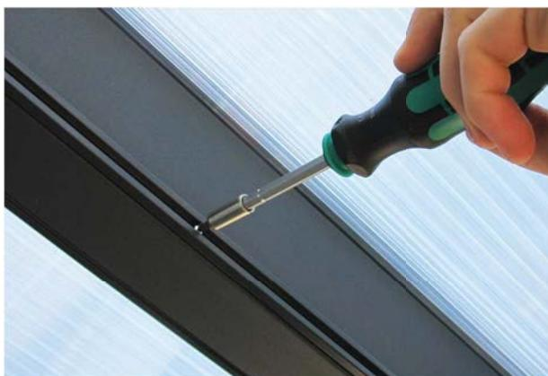
3.) Längsprofil anschrauben.
