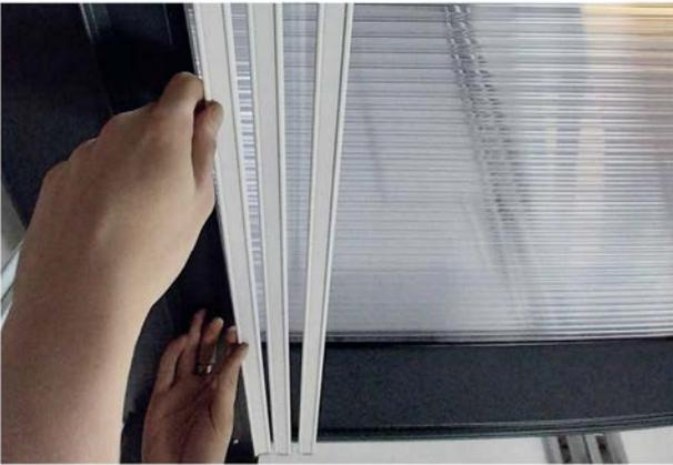
6.) Alle weiteren Klettprofile an der gegenüberliegenden Seite der Anlage in die Profile einschieben (wie bei 4.)
