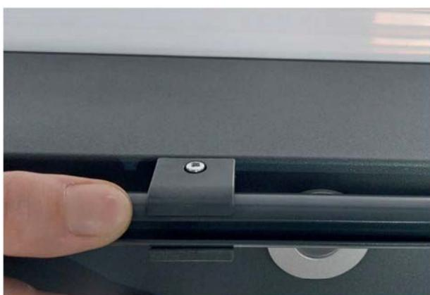
3.) Das Längsprofil in den Deckenclip einlegen - **Lauf senkrecht nach unten!**
