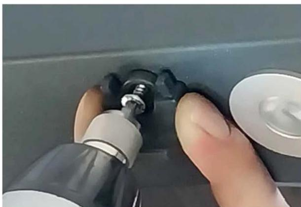
1.) Eine Hälfte des geteilten Deckenclips an die Decke schrauben.
