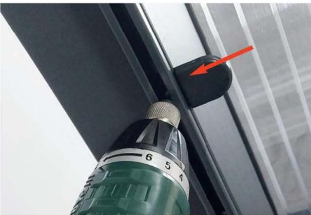
10.) Einen Magnetstopper am Ende des Paketmaßes zwischen Sparren und Profil klemmen und festschrauben.
