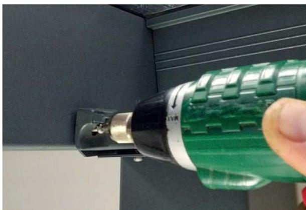
3. Eine Hälfte des Trägerclips anschrauben (Alle zwischenliegenden Clipse werden gemittelt und ca. alle 50 cm angebracht.)
