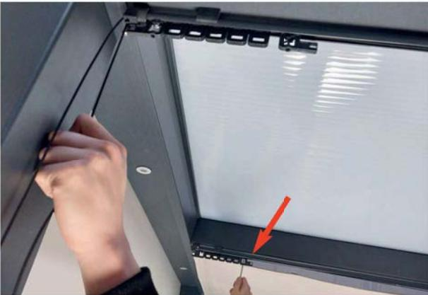
5.) Anlage spannen und bei Bedarf nachjustieren.
