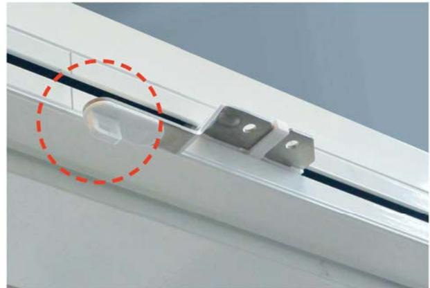
4.) Zugwagen setzen. Die Zugwagen müssen sich auf selber Höhe gegenüberstehen (bis zur Markierung auf dem Schienenprofil fahren).
