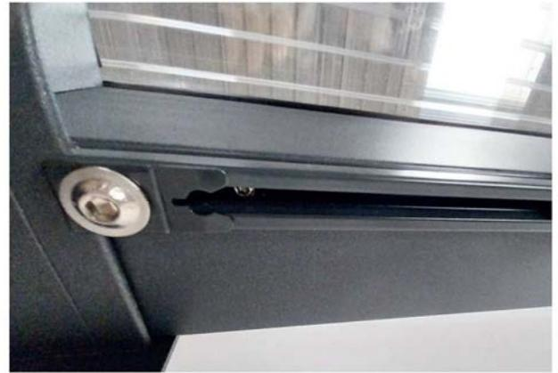
7.) Stopper an den Profilen einsetzen und fixieren (entgegengesetzt zu 3.).
