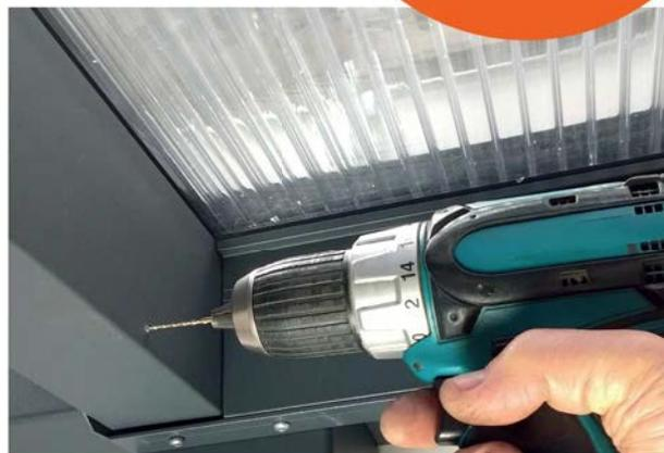
2.) Vorbohren (Der erste Trägerclip wird in einem Abstand von 7 cm vom Anlagenbeginn montiert, der letzte Trägerclip 7 cm vom Anlagenende.)
