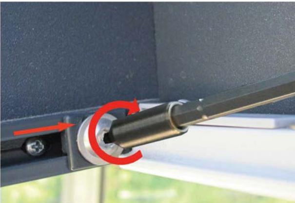
8.) Stopper in den Gleiter des Klettprofils drücken und festschrauben. Somit wird die Anlage an der Hausseite beim Bedienen fixiert.
