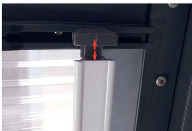
Unbedingt beachten, dass hinterher die Klettprofile so eingesetzt sind, dass sich alle beweglichen Gleiter auf einer Seite befinden und alle fixierten Gleiter auf der gegenüberliegenden Längsprofil-Seite.
