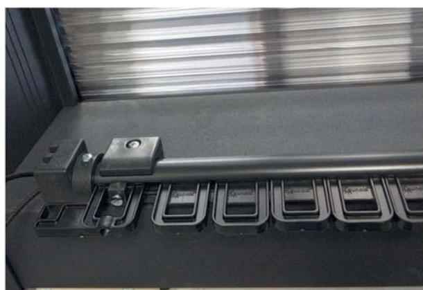
Ansicht Schiene mit Gleiter, Umlenker und Zugschnur montiert.
