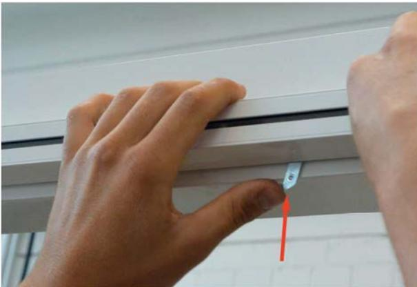
3.) Die Sicherung bis Schienenkante reindrücken (Sicherung befindet sich am Spannriegel)
